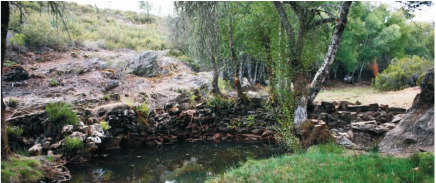
Azud del molino que será restaurado en Puebla de Sanabria.
